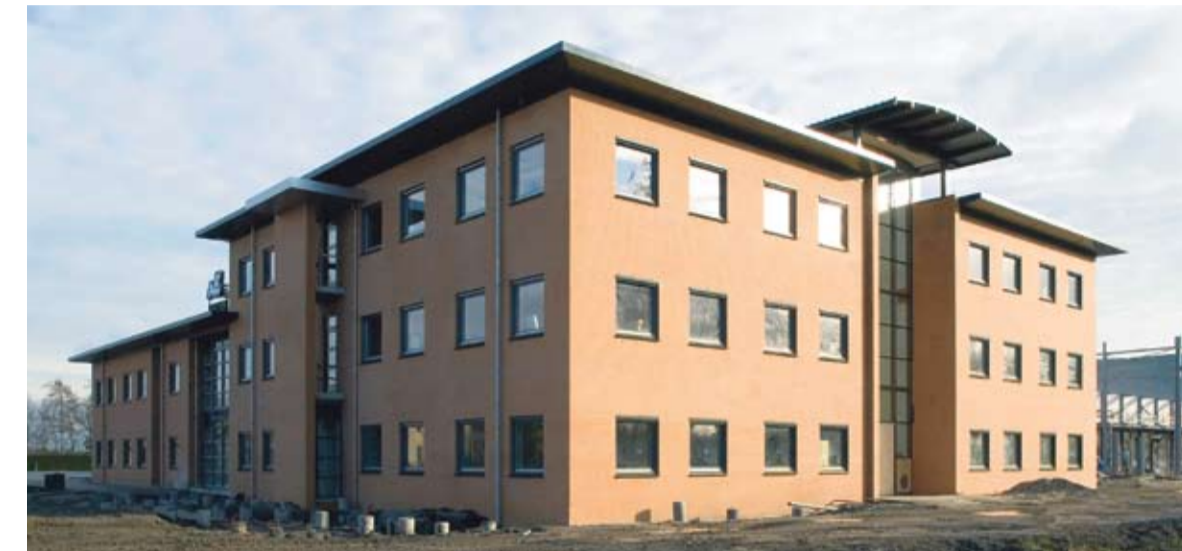
Nieuw kantoor Adriaan van Erk in aanbouw
